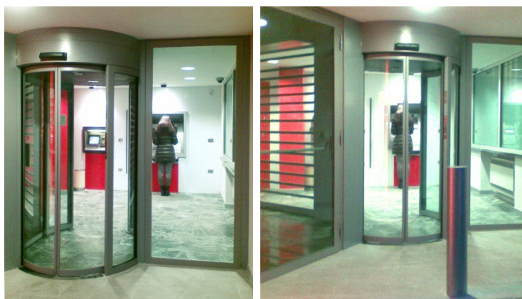
ESTERNO BANCA: INGRESSO AL PUBBLICO
